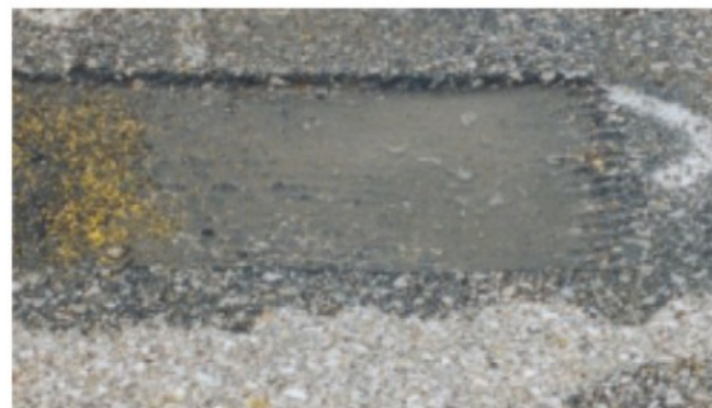
研磨方式在清除标识的同时也留下了一条痕迹
