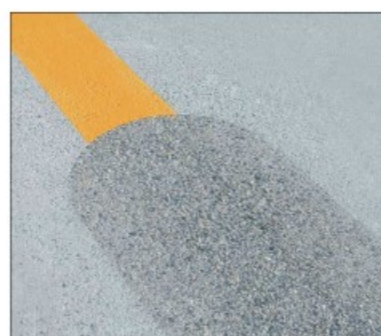
路标线可以完全清除干净，道路表面就可以重新涂装了
