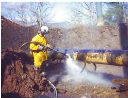
地下输送管道表层清除
