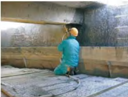
去除下水道设施劣化部
