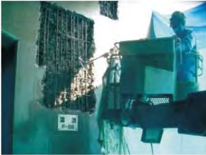
去除垂直面局部不达标混凝土
