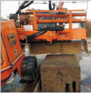
通过加长杆可以破碎缝隙中的混凝土
