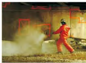
清除局部区域的劣化混凝土
