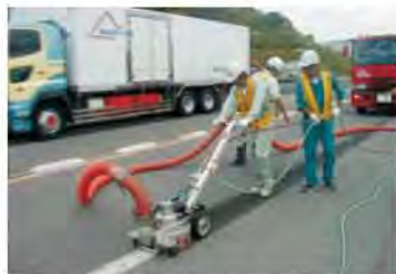
高速公路四车道改建工程
