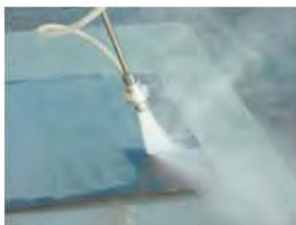
钢板表面除锈
