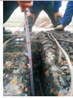
破碎伸缩缝混凝土
